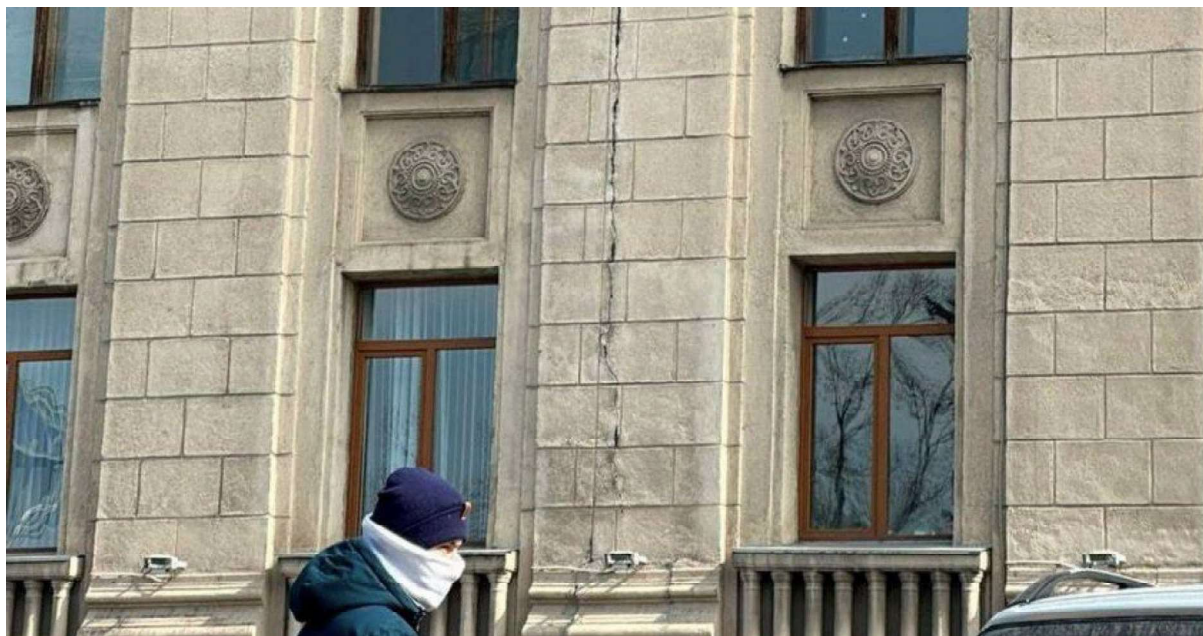
4 - сурет – Алматы қаласындағы әкімшілік ғимараттың фасадындағы жарықтар. 2024 жылғы сейсмикалық оқиғалардан кейінгі деформация белгілері
